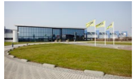
Zentrale von Rd4 in Heerlen
